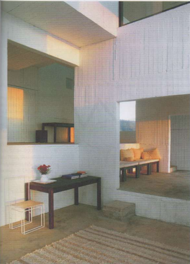
Im Inneren des Hauses sind die rauen Betonoberflächen weiß gestrichen und wechseln sich mit einer Holzvertüfelung ab, die aus den Schalungsbrettern gefertigt wurde.
