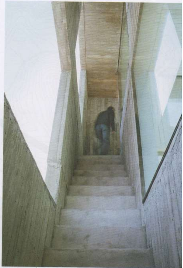
Diese Wand nimmt nicht nur die Erschließungswege und Loggien auf, sondern auch Bäder und Küche.
